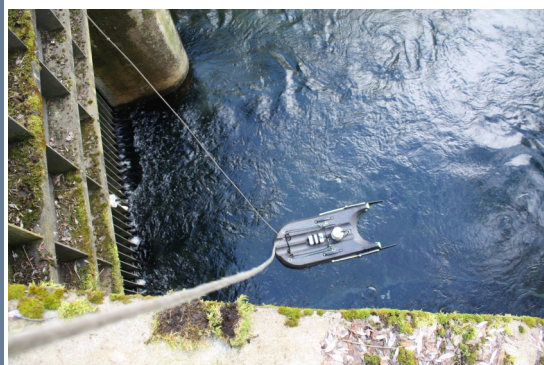
Mesure de débit en sortie de galerie du chenal de Moyeuve (S4)
